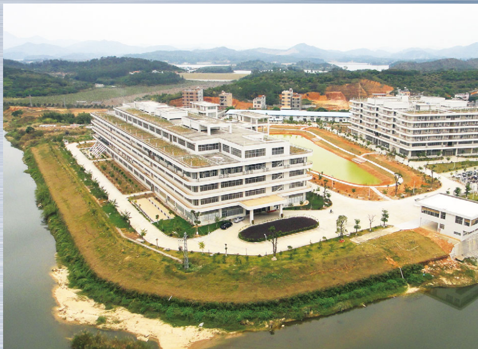
中國湖鎮東風村廠房及宿舍大樓
